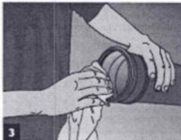
**Limpeza: (Fig.3)** Con trapo limpio se deben limpiar el enchufe (o campana) y la espiga o extremo macho, removiendo todo vestigio de polvo o grasitud que obstaculice la libre penetración de la espiga dentro del enchufe, o bien, que pueda atacar la guarnición de doble labio y disminuir su expectativa de vida útil.
